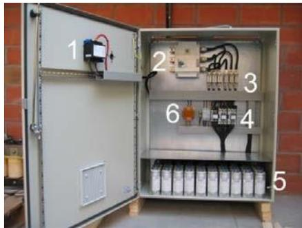
Figure 7: batterie de condensateurs (source: Wikipedia) avec '5' les condensateurs
